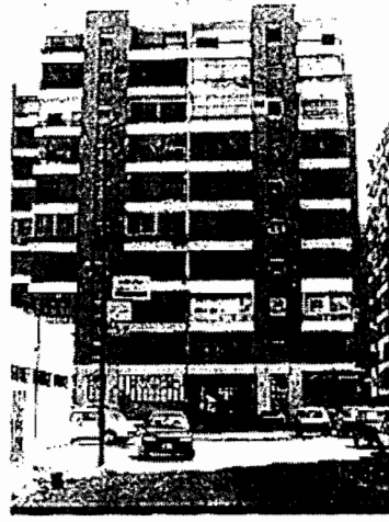
( شكل ٩، أ، ب) الآثار الناتجة عن ضم البلكونات إلى الحيز الداخلي بمختلف أنواعه على الواجهات
